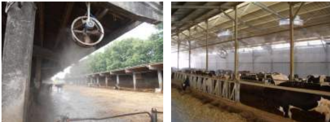
Figura 18 – Sistemi di nebulizzazione associati alla ventilazione artificiale
