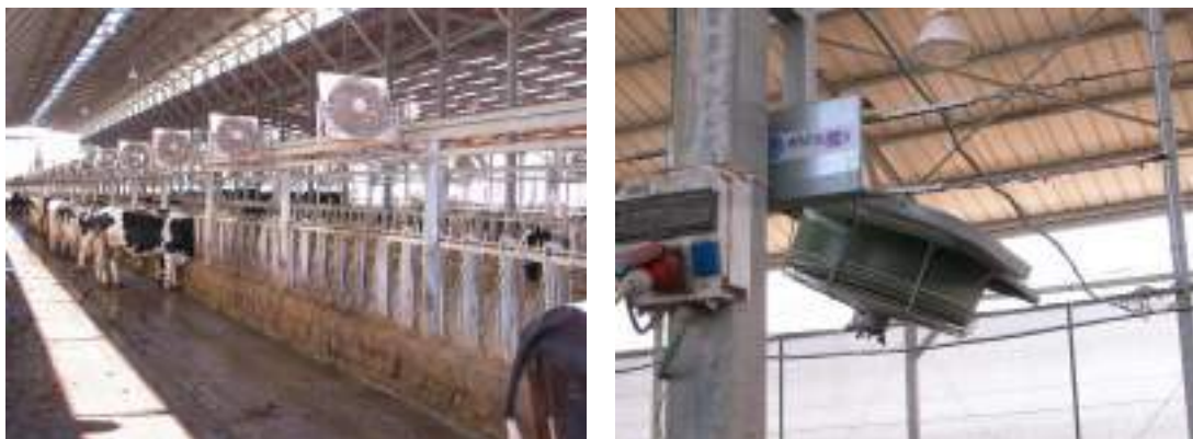
Figura 15 – Ventilatori di dimensioni contenute fissi (a sinistra) e orientamento variabile mediante trasmissione a catena (a destra).
