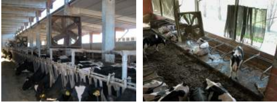
Figura 14 – Ventilazione artificiale con ventilazioni ad asse orizzontale in zona di alimentazione (a sinistra) e di riposo (a destra).
