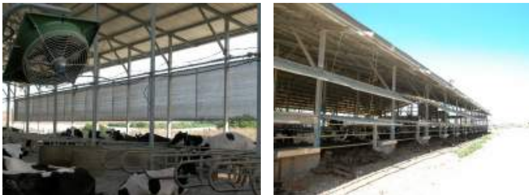
Figura 9 – Utilizzo di reti ombreggianti (a sinistra) e di sporti ombreggianti per limitare l'esposizione ai raggi solari e limitare l'intensità luminosa nella zona di stabulazione
