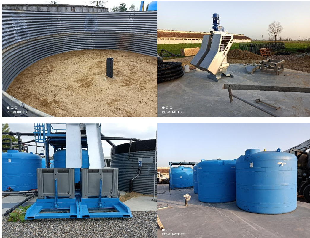
Figura 4 – Fasi del montaggio dell'impianto. In alto a sinistra, vasca di ricezione. In alto a destra, separatore. In basso a sinistra, contenitori per il separato palabile. In basso a destra, contenitori posizionati.
