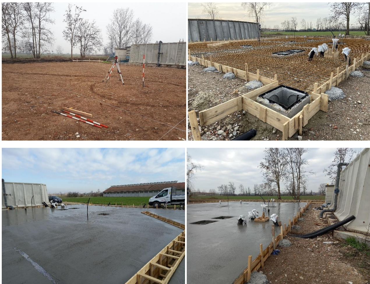
Figura 3 – Fasi della realizzazione della platea. In alto a sinistra, tracciamento dell'area. In alto a destra, armatura e predisposizione dei tubi. In basso, platea gettata.
