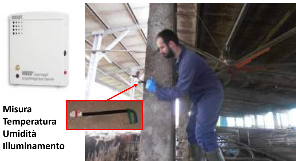
Figura 23 – data logger per la registrazione dei dati microclimatici e loro installazione in stalla
