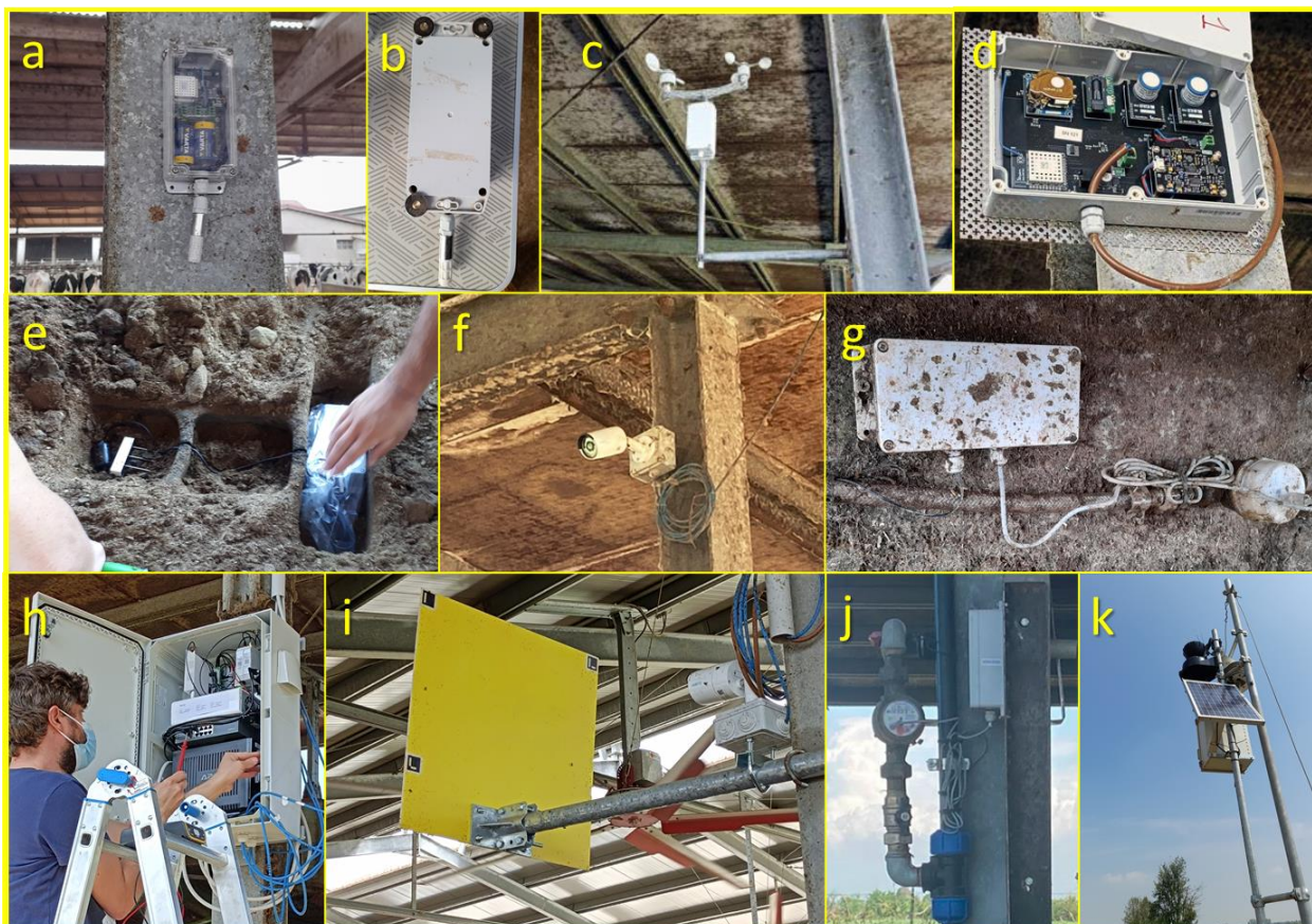
Figura 4: Installazione dei sensori presso Cascina S. Francesco. a: sensore N1, b: retro del sensore N1 con magneti, c: sensore N6, d: sensore N5 (aperto), e: sensore N4, f: telecamera, g: sensore N3 (per acqua potabile), h: centraline (aperto), i: camera conta mosche, j: sensore N3 (per le doccette), k: stazione meteorologica con gateway esterno.
